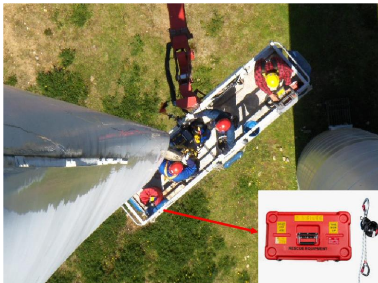
Abbildung 10-1: Beispiel für einen Notabstieg an einem Mannkorb
