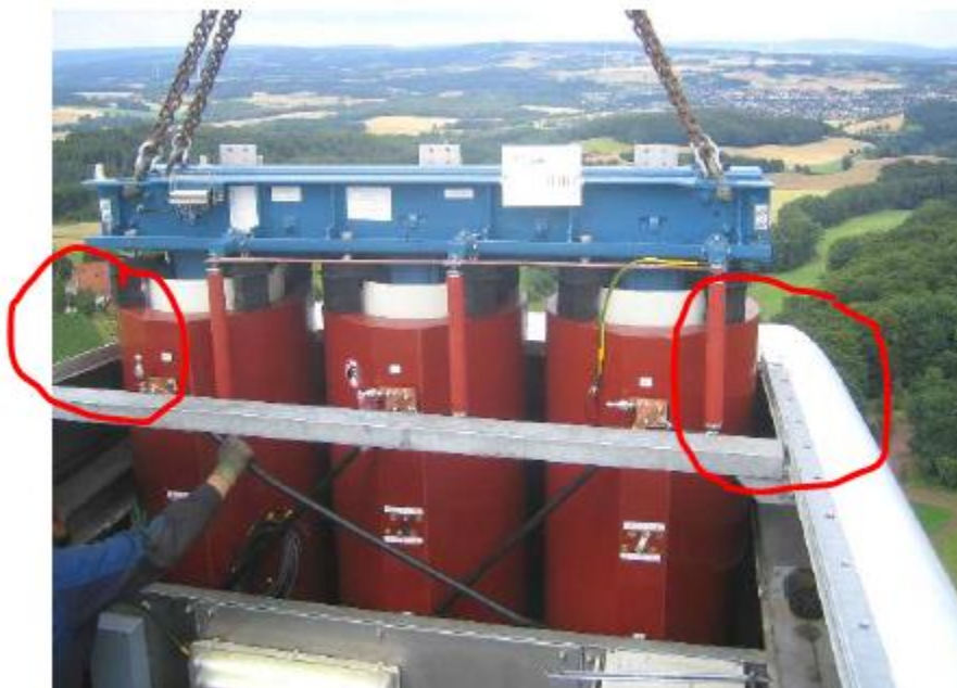
Abbildung 18-1: Führen des Transformators in das Maschinenhaus
