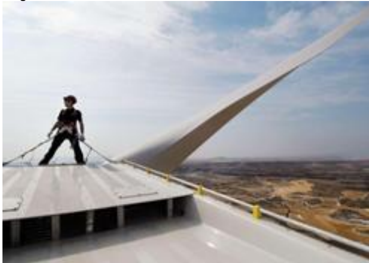
Abbildung 10-2: Arbeiten auf dem Maschinenhaus
