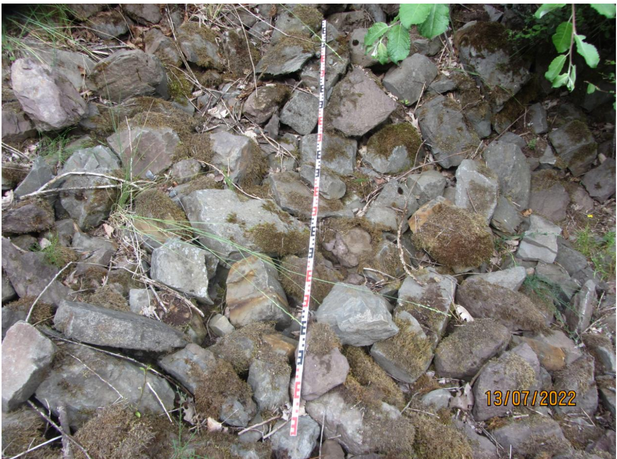
Abbildung 1: Steinschüttung des bestehenden Raubettgerinnes, exemplarische Fotodokumentation
