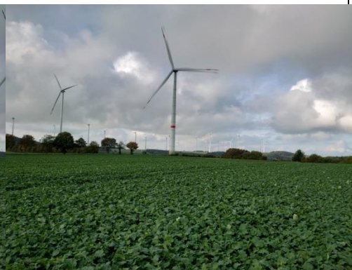
Blick nach Westen auf WEA 8
