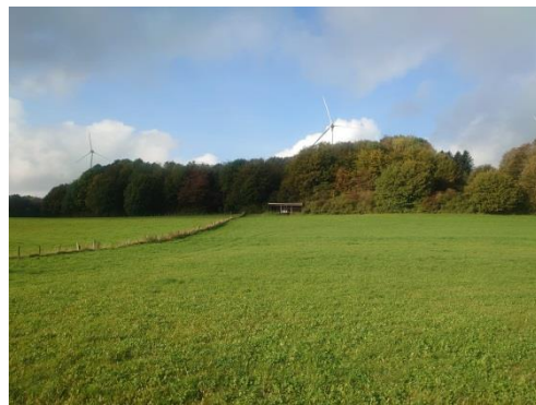
Blick nach Südwesten
