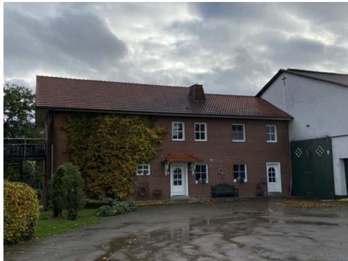
Abbildung 9.11: Nordansicht IO-10 (Ellerweg 7; 33184 Altenbeken)
