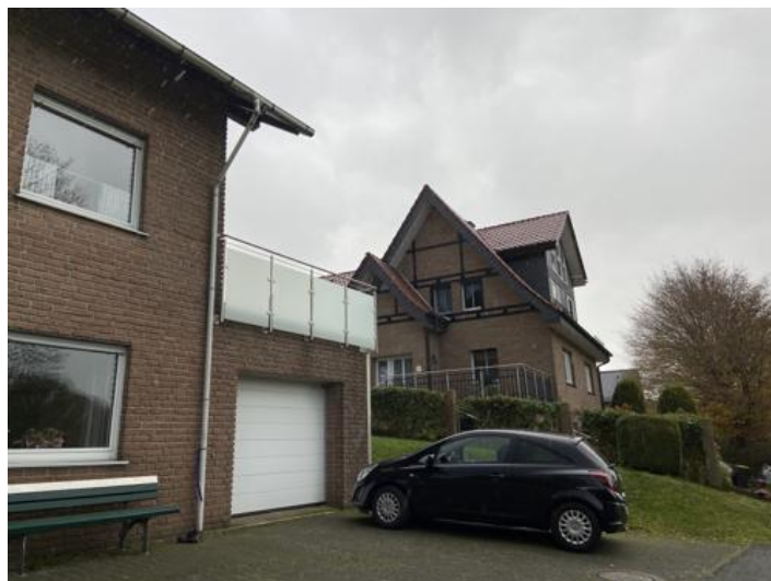
Abbildung 9.15: Nord-Westansicht IO-14 (Rotenbach 26; 33184 Altenbeken)
