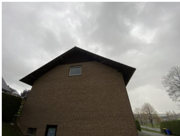
Abbildung 9.7: Nordansicht IO-07 (Rotenbach 27; 33184 Altenbeken)
