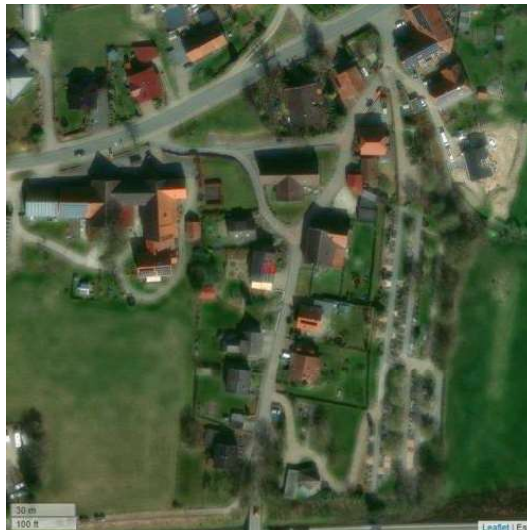
Abbildung 8.169: Satellitenansicht SR-169 (Dionysiusstraße 6; 33184 Altenbeken)
