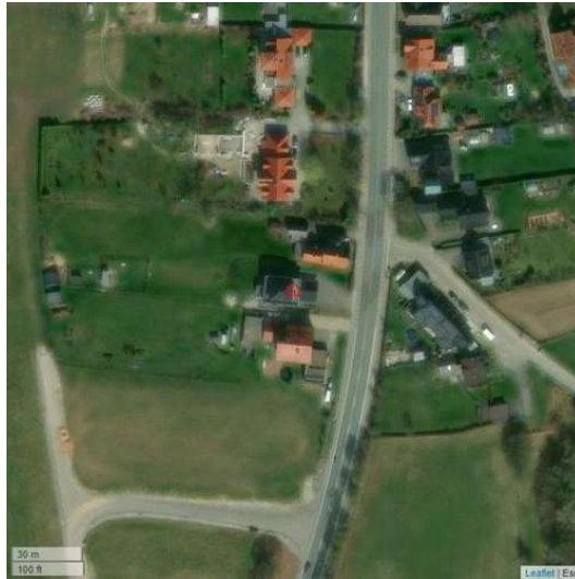
Abbildung 8.232: Satellitenansicht SR-232 (Schwaneyer Straße 18a; 33184 Altenbeken)
