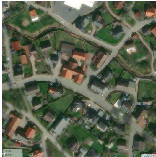
Abbildung 8.67: Satellitenansicht SR-067 (Brückenstraße 1; 33184 Altenbeken)
