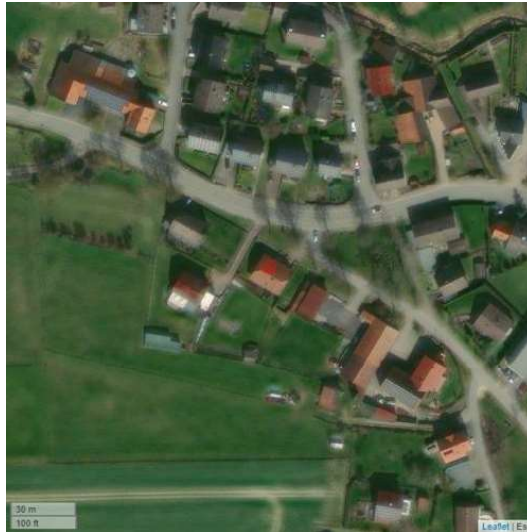
Abbildung 8.28: Satellitenansicht SR-028 (Hellweg 35; 33184 Altenbeken)
