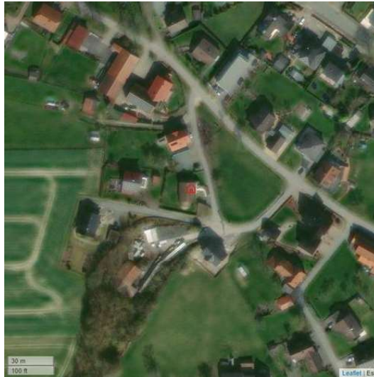
Abbildung 8.54: Satellitenansicht SR-054 (An der Gräfte 2; 33184 Altenbeken)
