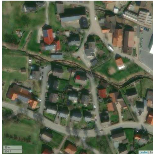
Abbildung 8.32: Satellitenansicht SR-032 (Am Brokhof 9; 33184 Altenbeken)
