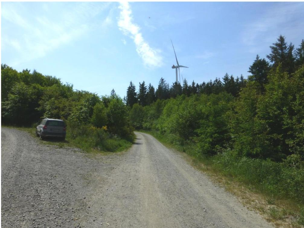
Abbildung 3.4: Bestehende Zuwegung südlich des WEA-Standorts 1 (Windpark Wilnsdorf); der Kurvenausbau zur geplanten WEA 4 führt durch den jungen Buchenbestand rechts des Weges
