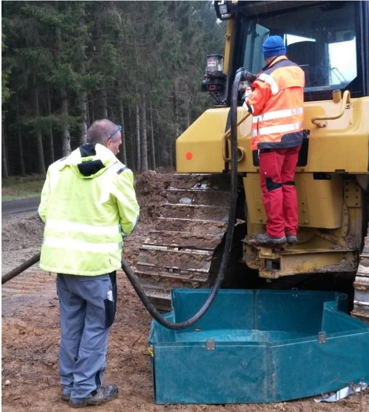
Abbildung 7: Empfohlene Maßnahme: Betankung der Baumaschinen im Baufeld von 2 Personen mit faltbarer Auffangwanne
