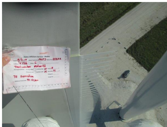
Bild 3: Sägezähne nach der Montage an einem Blatt oben am Turm
