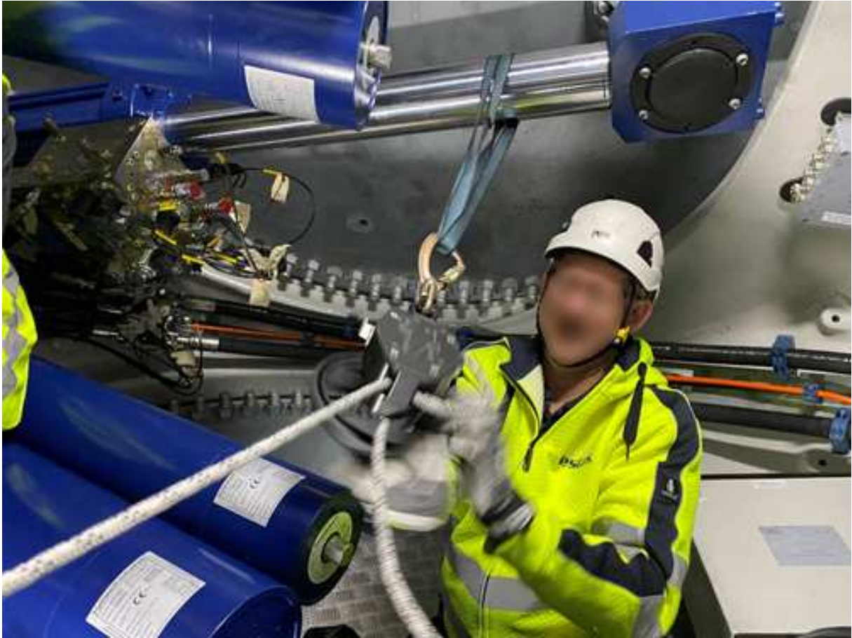
Abbildung 7.27: Befestigung der Notabstiegsvorrichtung am Pitchzylinder
