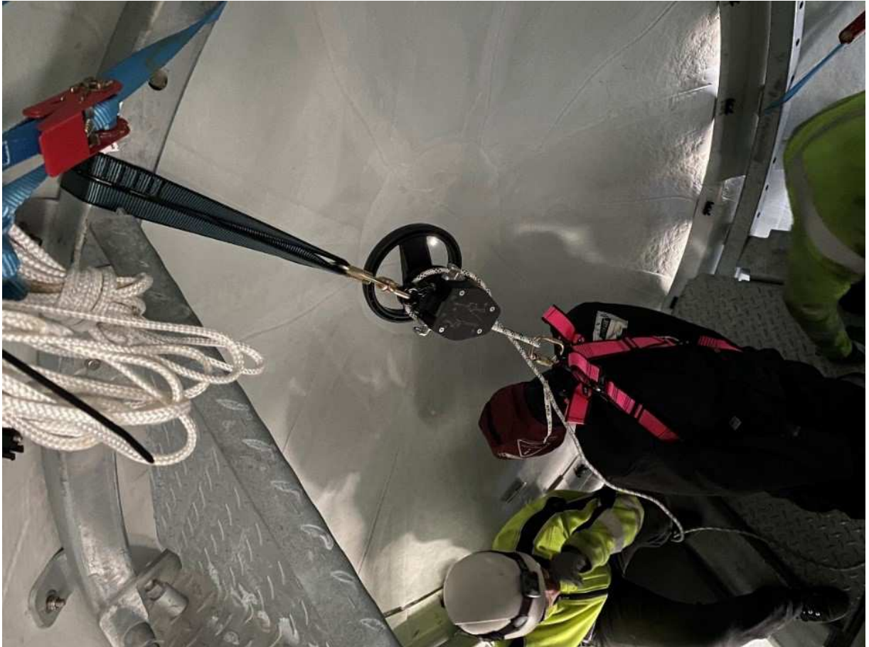
Abbildung 7.30: Aufhängung der Notabstiegsvorrichtung an der Spinnerringkonstruktion
