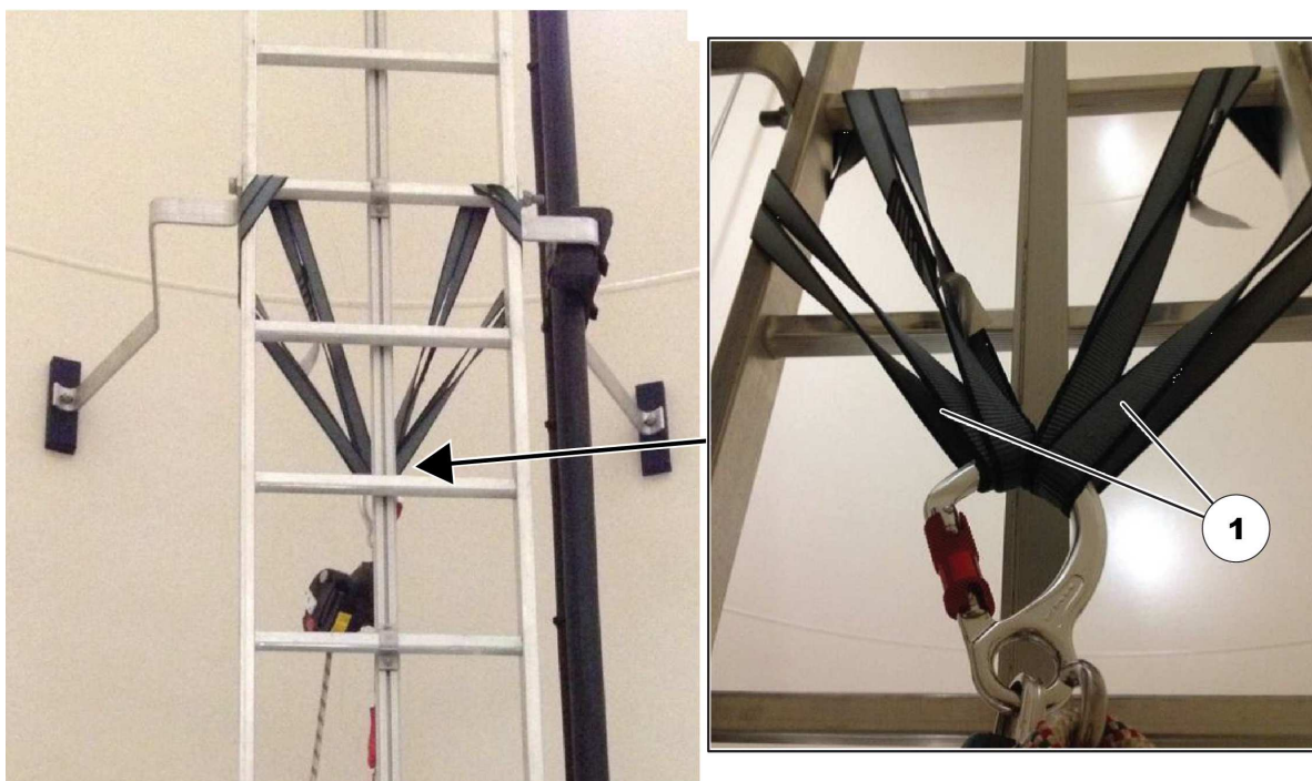
Abbildung 7.35: An der Turmleiter befestigte Notabstiegsvorrichtung
