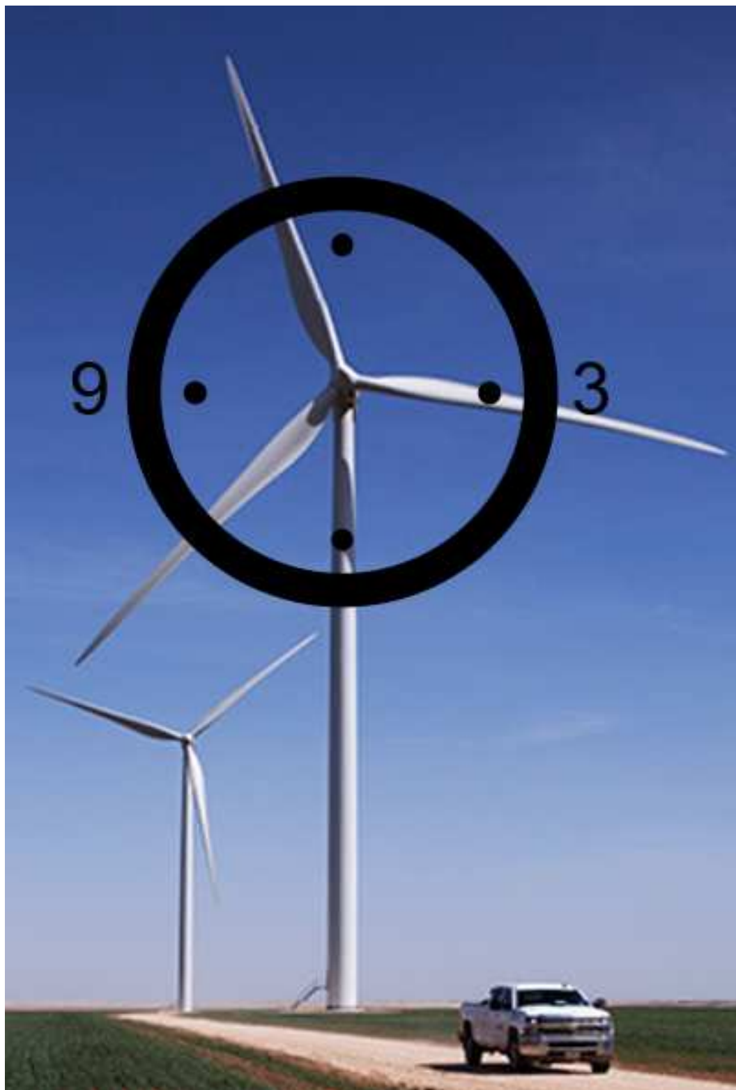
Abbildung 7.22: 3-Uhr-Stellung des Blatts
