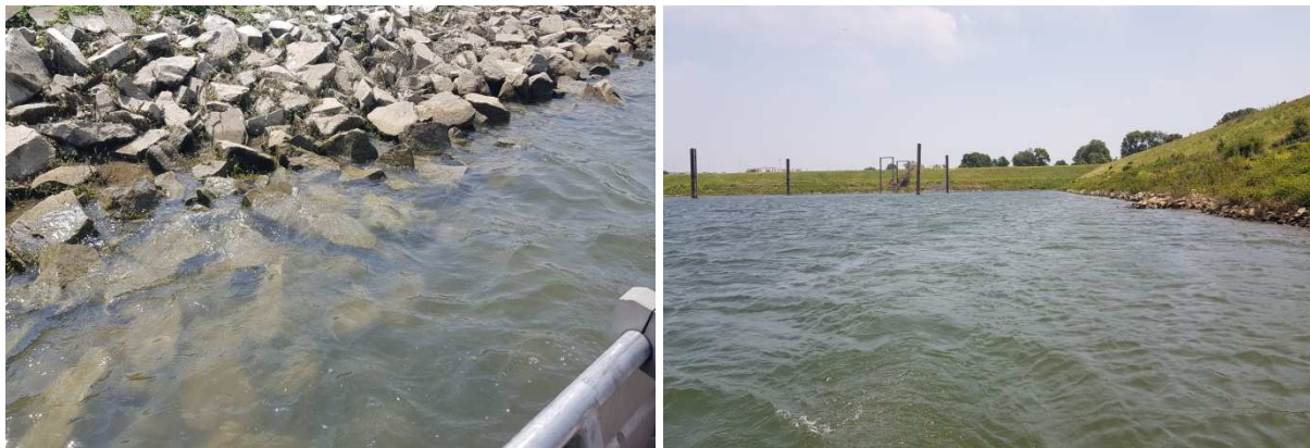
Abbildung 24 und 25: Typischer Uferbereich mit Wasserbausteinen (l.) und homogene Uferlinie im Betrachtungsbereich I (r.).
