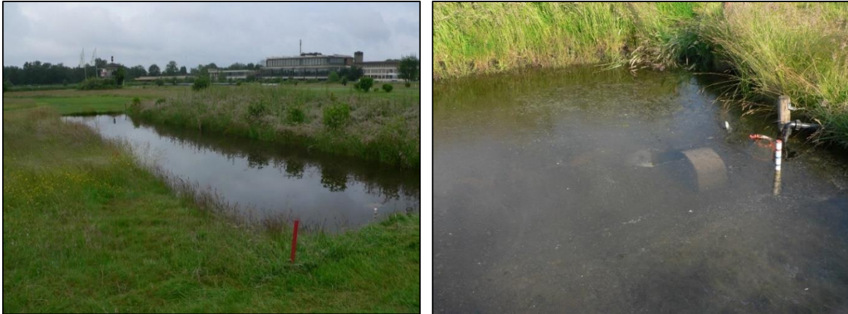
Abbildung 6: Gewässer 2 - Regenrückhaltebecken im nördlichen Bereich des Golfplatzes (rechts: vorhandene Pumpe)
