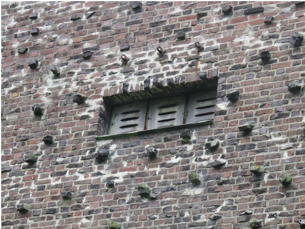
Abbildung 5: Lüftungsgitter auf der Ostseite
