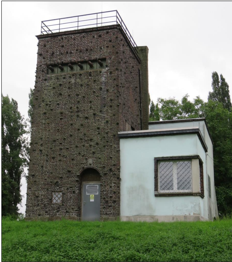
Abbildung 4: Denkmalgeschütztes Reservewasserwerk (Pumpstation)
