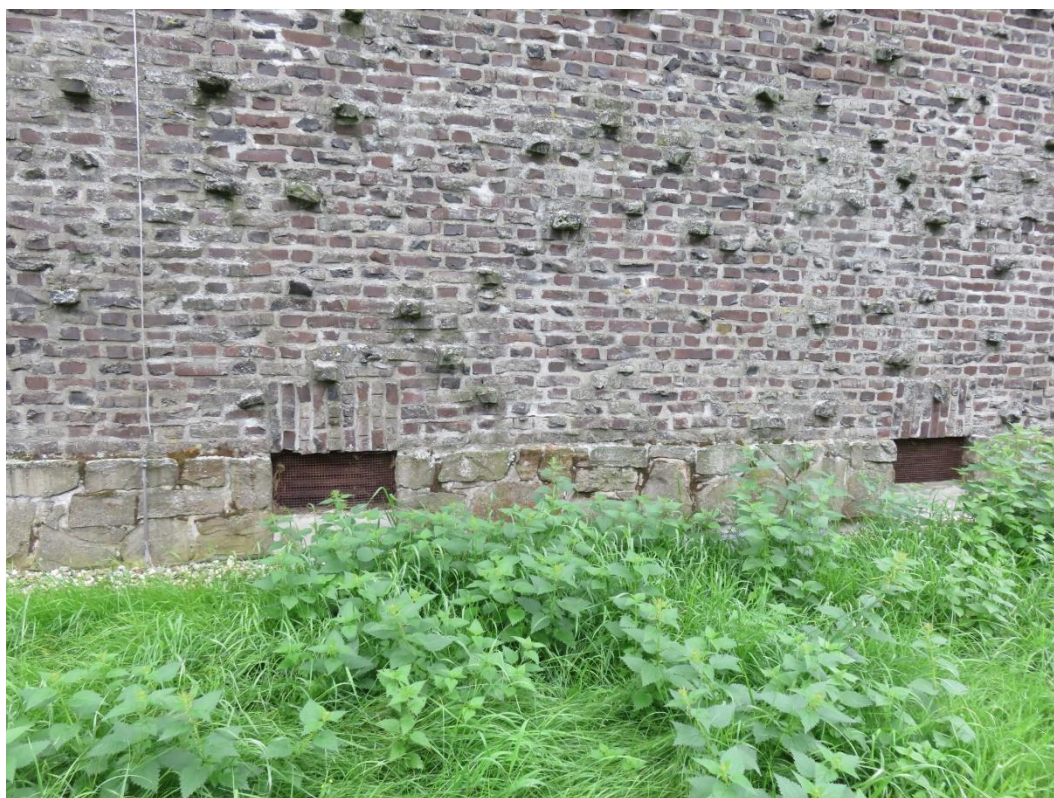
Abbildung 6: Lüftungsfenster im Sockelbereich des Turms
