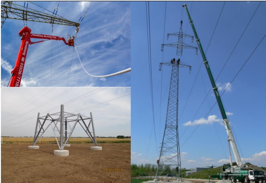
**Abbildung 5: Errichtung der Masten**
