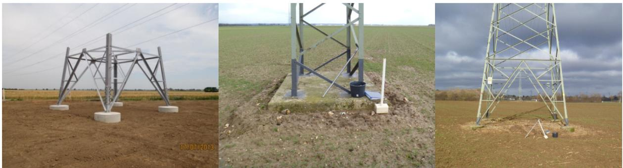
**Abbildung 8: Geplantes Plattenfundament sowie bestehende Block- bzw. Stufenfundamente**
