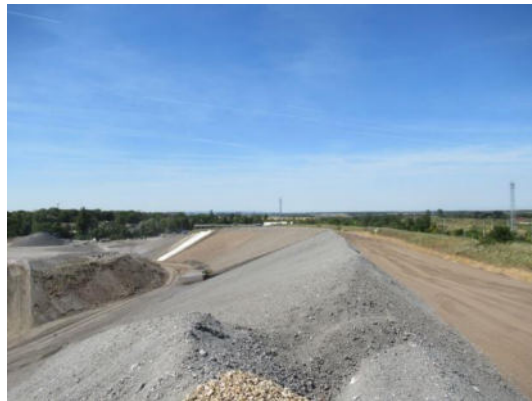
Abb. 22 Derzeitiger Verfüllbereich S' der Anlehnungsböschung der Zwischenabdichtung auf den Altteil der Deponie.
