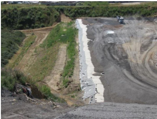
Abb. 21 E' Ausbaugrenze der Basisabdichtung des Deponieabschnittes DA 4b.
