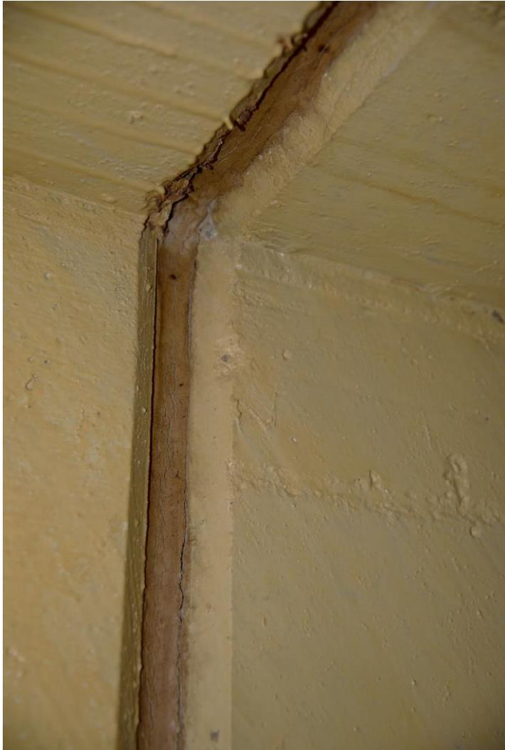
Abbildung 3: Schachtfuge im Schrägschacht DA 2. Erkennbar sind nur leichte Bewegungrisse in der Fugenabdeckung (Aufnahme durch das Büro Dr. Paas vom 26.11.2021)
