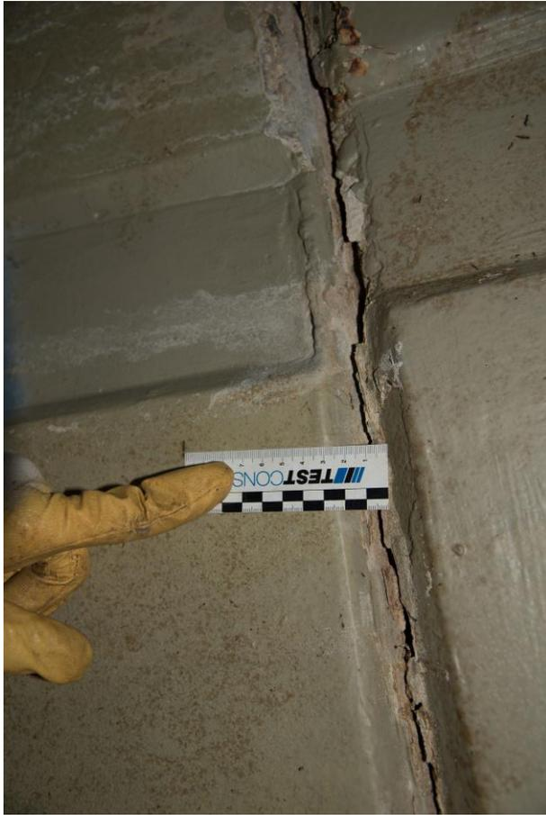
Abbildung 4: Schachtfuge im Schrägschacht DA 3.1. Erkennbar sind nur leichte Bewegungsrisse in der Fugenabdeckung (Aufnahme durch das Büro Dr. Paas vom 26.11.2021)
