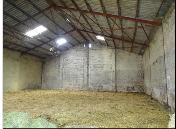
Abbildung 4: Innenansicht der Scheune vom Gut Marienhof.
