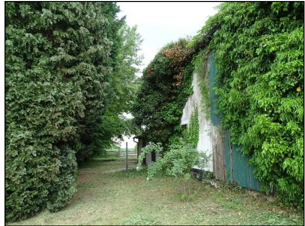
Abbildung 6: Außenansicht der Scheunen-Rückwand vom Gut Marienhof.
