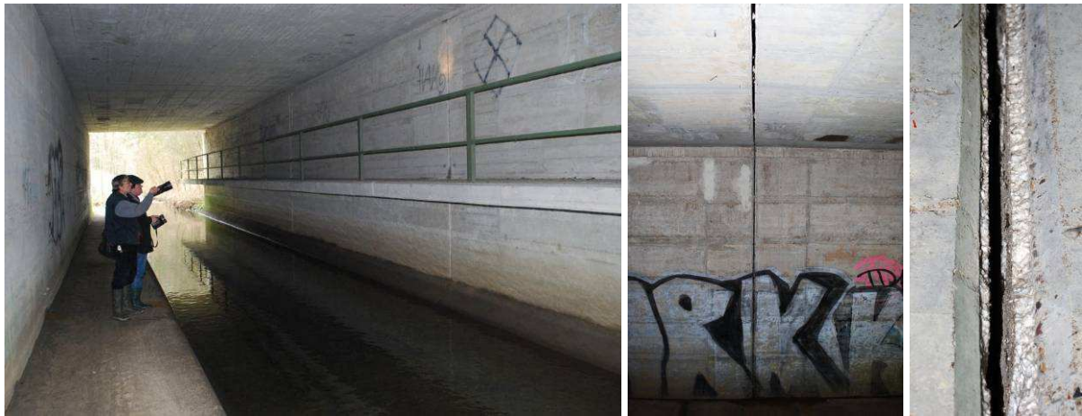
Abb. 2: Die Beverbachbrücke ist eine Betondurchlass, der vier durchgehende Längsspalten zwischen den Betonblöcken besitzt.
