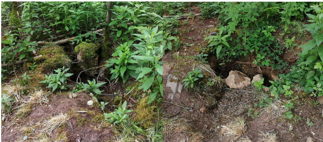
Abb. 11: Einzelne Betonbrocken und Eisenarmierungen im Bereich der Senke (Fotos: Wolfgang Wegener).
