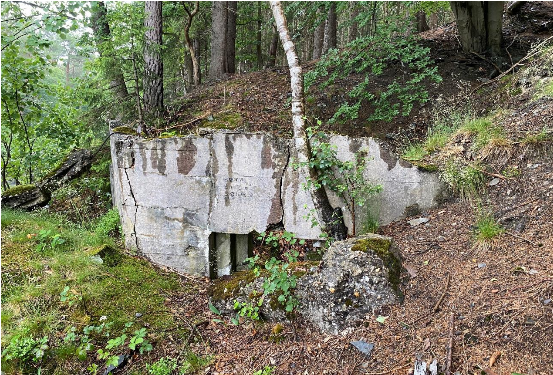
Abb. 08: Überreste einer angesprengten Betonverstärkung für eine Maschinengewehrstellung (OA 1997/1251) an der L238 (Foto: Karin Schramme).
