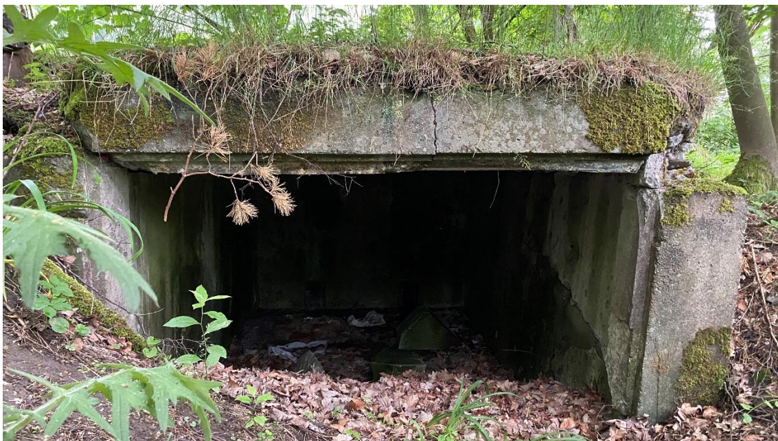
Abb. 07: Pak-Garage OA 1997/1247 westlich der L238 (Foto: Karin Schramme).
