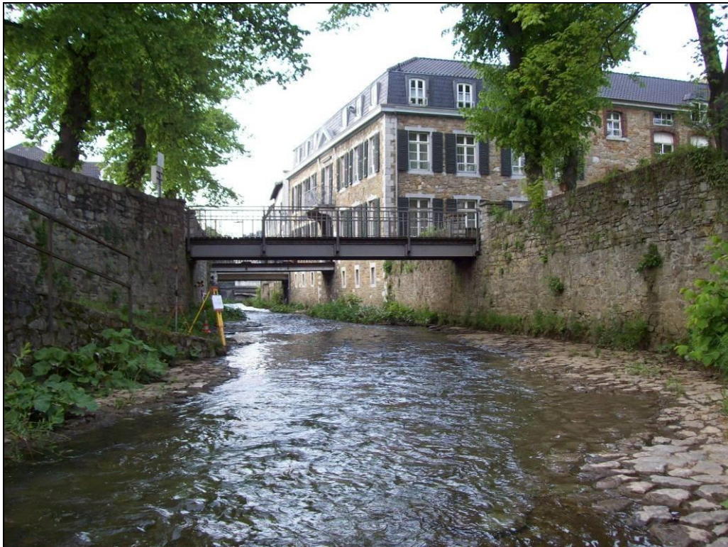
Bild 5.6: Rückstaubereich oberhalb von drei Bauwerken (km 3,270)
