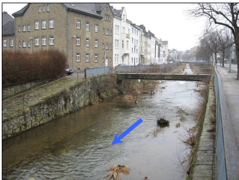
Bild 6.2: Steg - km 1,131 - Blick gegen die Fließrichtung
