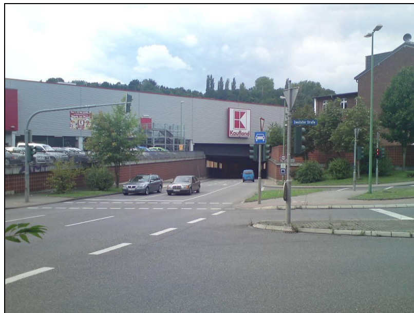
Bild 6.11: Zufahrt Tunnel Europastraße (Blick nach Norden)
