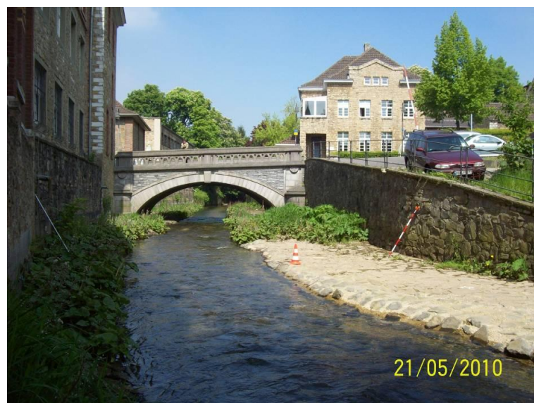
Bild 6.4: Rampe am rechten Ufer, oberhalb Brücke "Steinfeldstraße"
