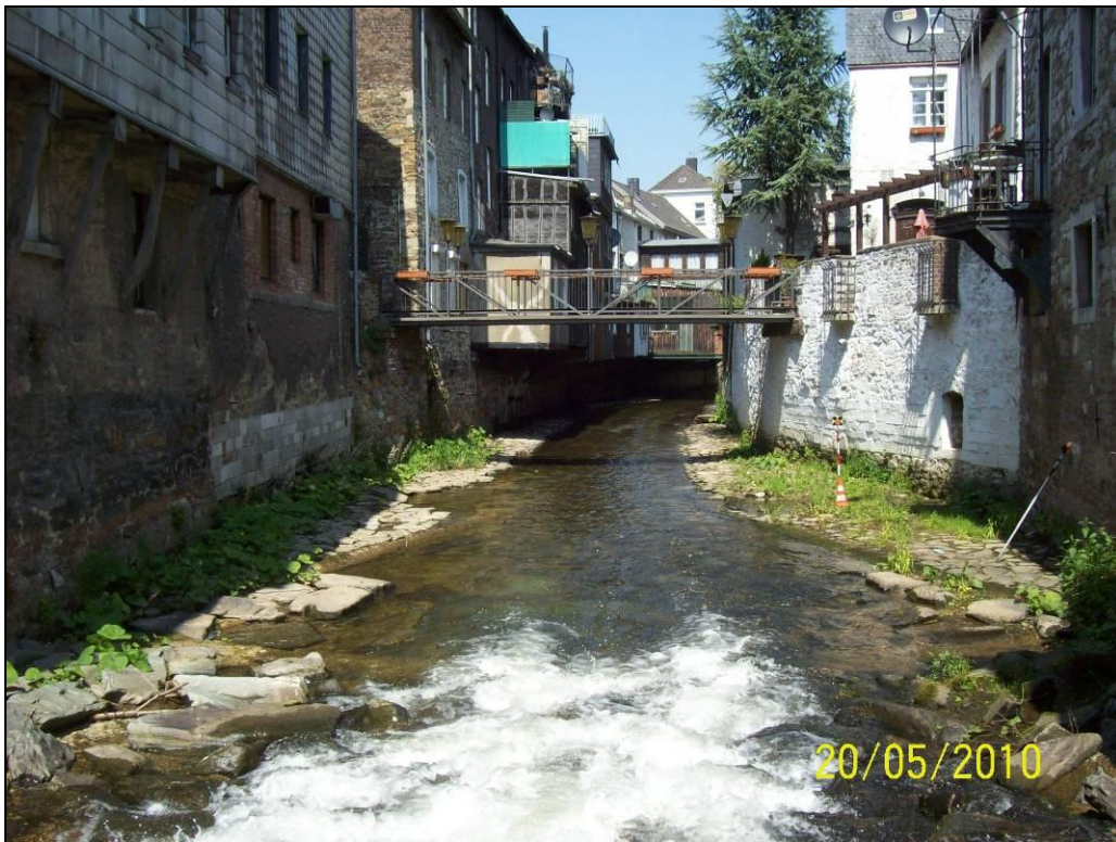
Bild 5.1: Vermessung Vicht, Mai 2010- km 3,041 (UW Gleite) - Blick in Fließrichtung
