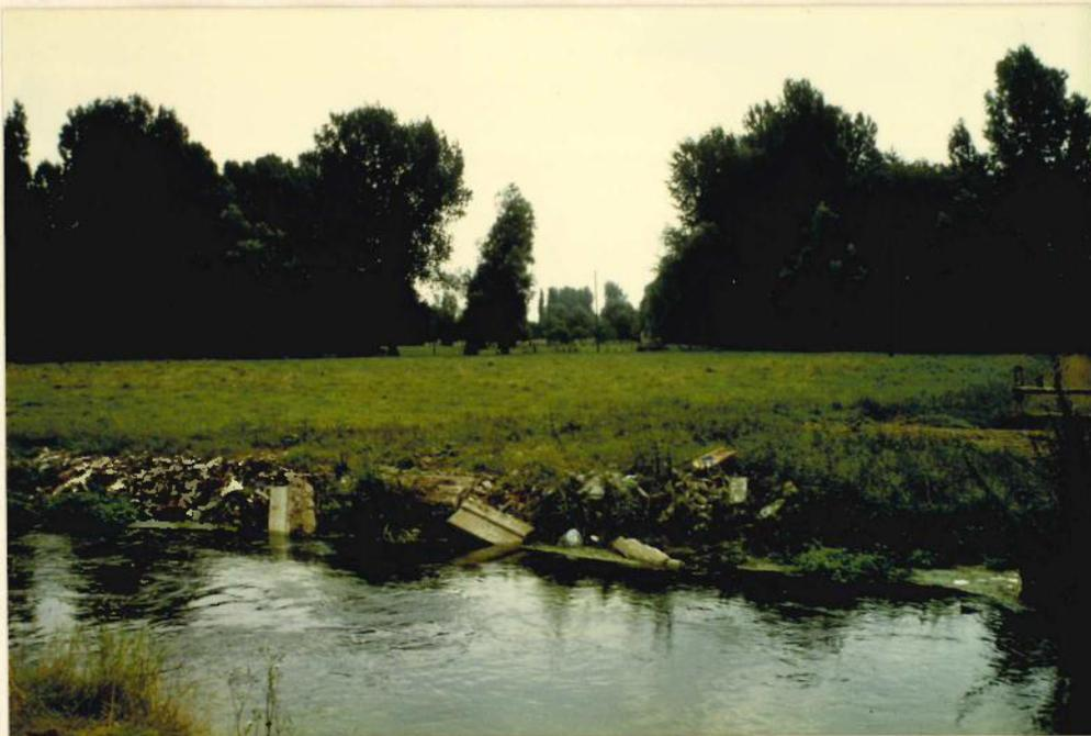
Abb. 20: "Uferbefestigung" der Heder mit Bauschutt.
