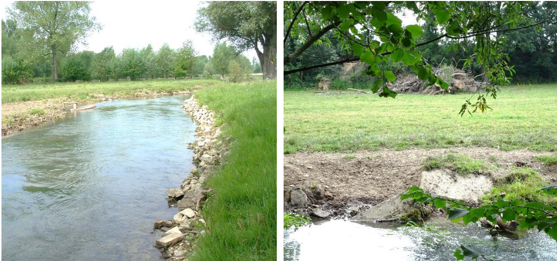
Abb. 3-2: Uferbefestigungen an der Heder und Uferabbrüche im Bereich schadhafte Befestigungen südlich der Straße Stadtteiche
