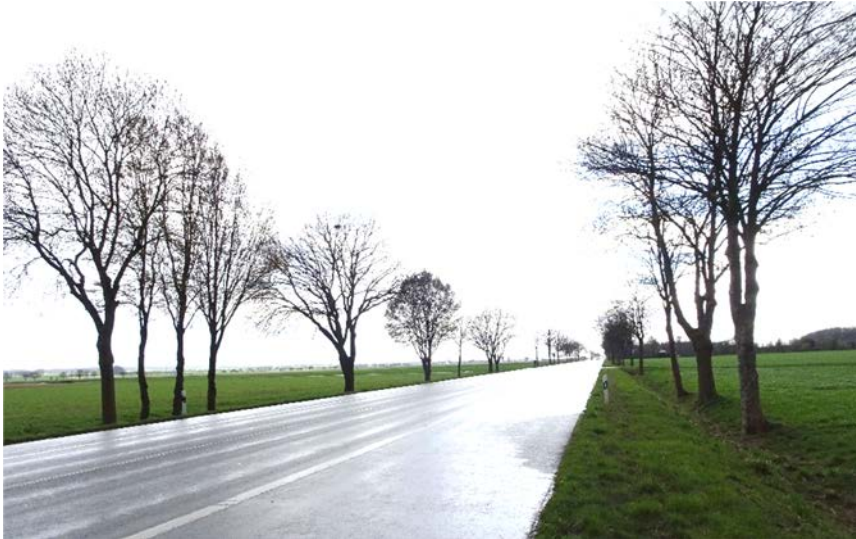
B 1 alt mit den begleitenden Baumreihen (Blick Richtung Westen)
