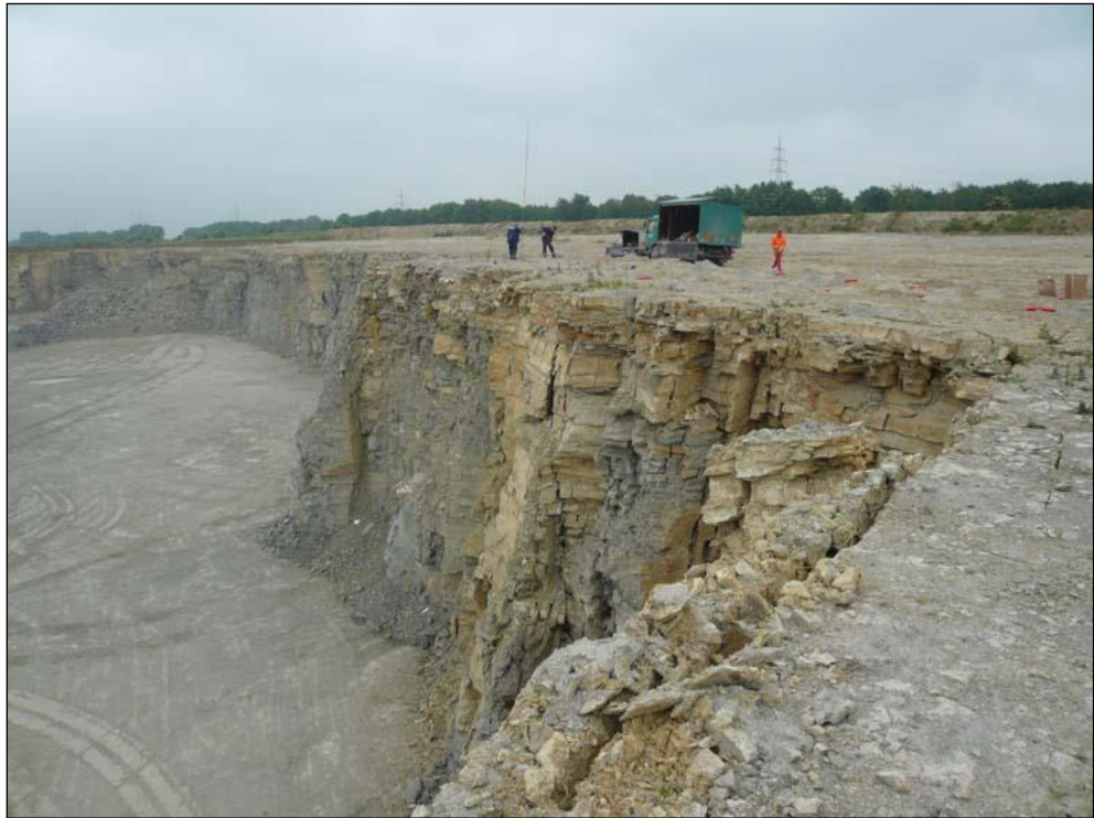
Abb. 7 Bruchwand vor der Sprengung
