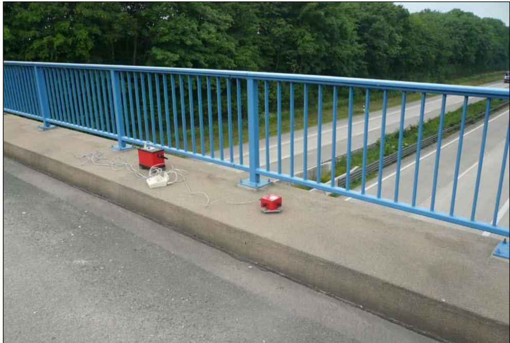
Abb. 10 MP 4-6, Fahrbahnplatte der Autobahnbrücke
