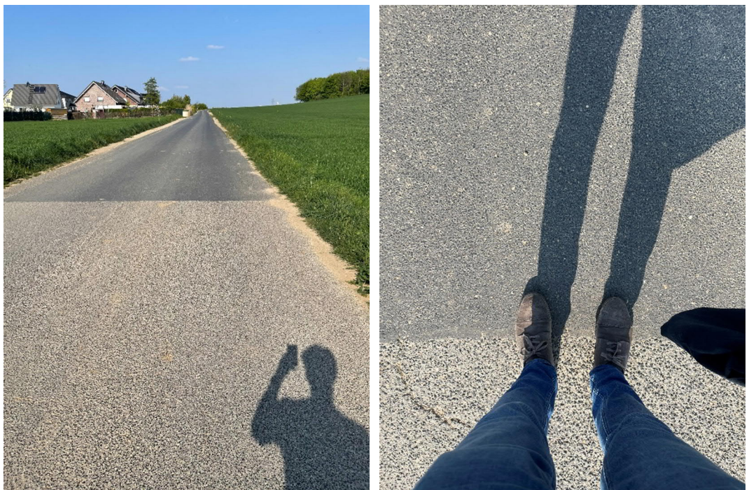
Abbildung 6: Übergangsbereich im südlichen Teil der Zufahrt Südost.
