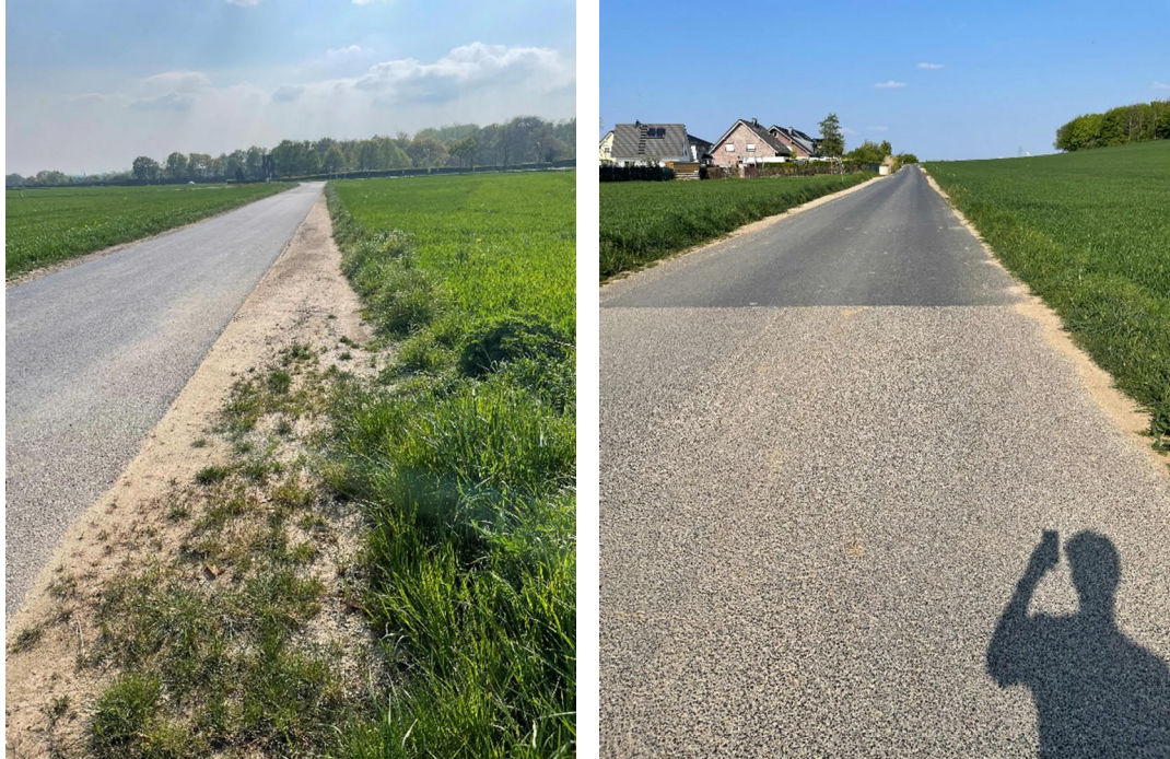
Abbildung 5: Zustand der Zufahrt Südost im südlichen Bereich
