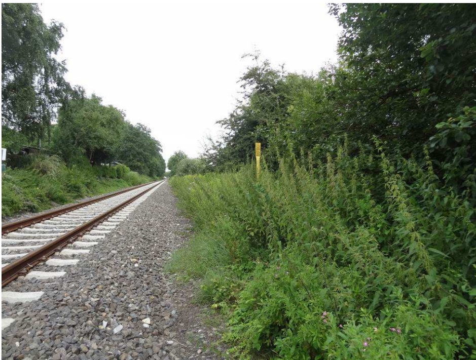
Abb. 1: Typisches Bild des Neuverlegungsabschnitts in gleicher Trasse entlang der Bahnlinie
