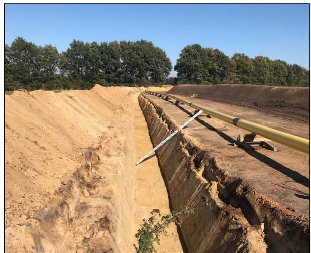
**Abbildung 16: Rohrgraben und Leitung in DN 300**
