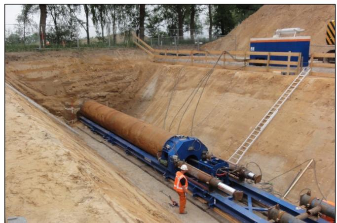
**Abbildung 21: Pressgrube mit Pressgerät (Ltg. DN 1400)**
