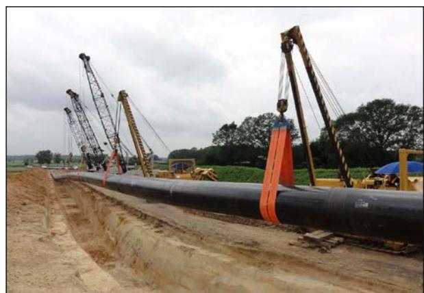
**Abbildung 17: Absenken des Rohrstranges (Ltg. im Bild mit DN 1.000)**
