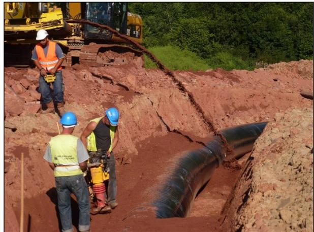
**Abbildung 18: Verfüllen des Rohrgrabens (Ltg. im Bild mit DN 1.000)**
