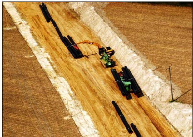
**Abbildung 14: Rohrausfuhr im Arbeitsstreifen**
