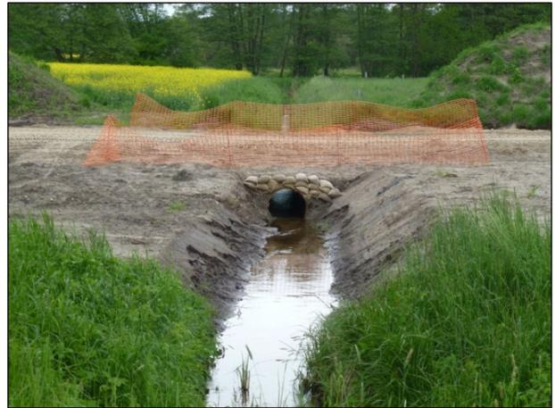
**Abbildung 20: Überfahrt an wasserführendem Graben**
