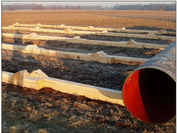
**Abbildung 10: Holzbalcken zum Lagern der Rohre (Bsp. DN 1000)**
