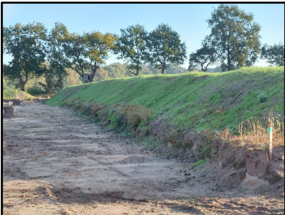
Foto 3: Begrünung der Haufwerke / Bodenmieten Blickrichtung nach Osten Stand 12.10.2022
