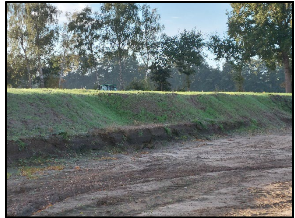
Foto 2: Begrünung der Haufwerke / Bodenmieten Blickrichtung nach Südwesten
