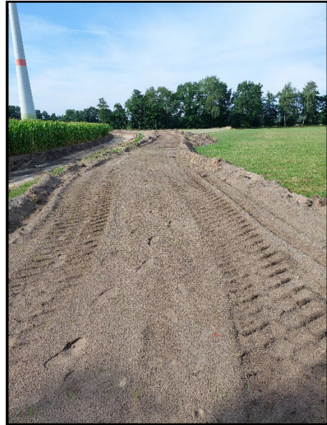
Foto 2: Befahrene Bodenmiete Blickrichtung nach Westen Stand: 25.07.2022
