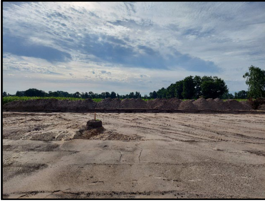
Foto 5: Baufläche mit abgeschobenem Oberboden Blickrichtung nach Süden Stand: 25.07.2022
