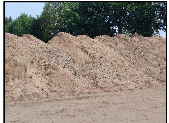
Foto 4: Haufwerk mit Mächtigkeit > 2 m Nordosten Stand: 04.08.2022
