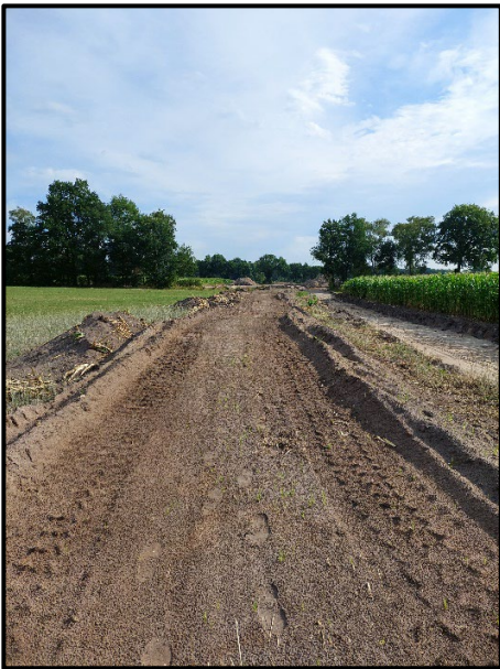
Foto 1: Befahrene Bodenmiete Blickrichtung nach Osten Stand: 25.07.2022
