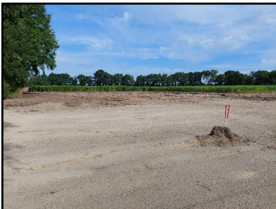
Foto 3: Baufläche mit abgeschobenem Oberboden Blickrichtung nach Norden Stand: 25.07.2022
