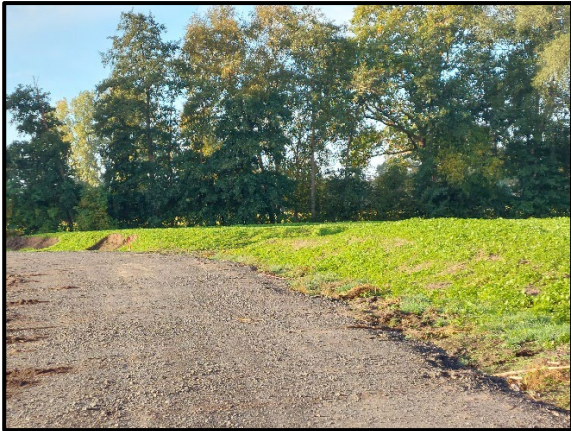
Foto 1: Begrünung der Haufwerke / Bodenmieten Blickrichtung nach Westen Stand 12.10.2022
