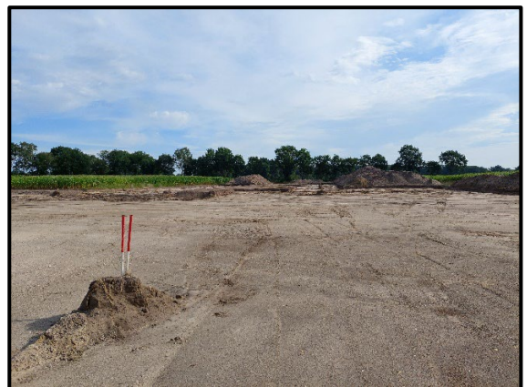
Foto 4: Baufläche mit abgeschobenem Oberboden Blickrichtung nach Osten Stand: 27.07.2022
