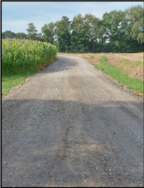
Foto 1: Schottereinbau Zuwegung Blickrichtung nach Westen Stand: 04.08.2022
