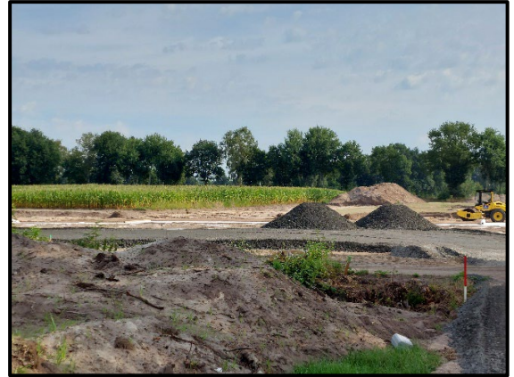
Foto 2: Schottereinbau im Bereich der WEA Blickrichtung nach Osten Stand: 04.08.2022
