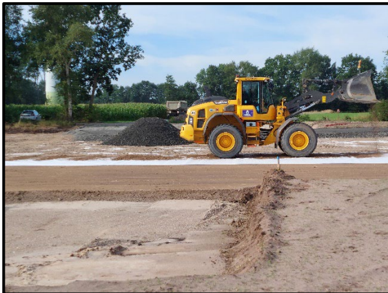
Foto 3: Verlegung des Kombigitters und Schottereinbau Blickrichtung nach Westen Stand: 04.08.2022
