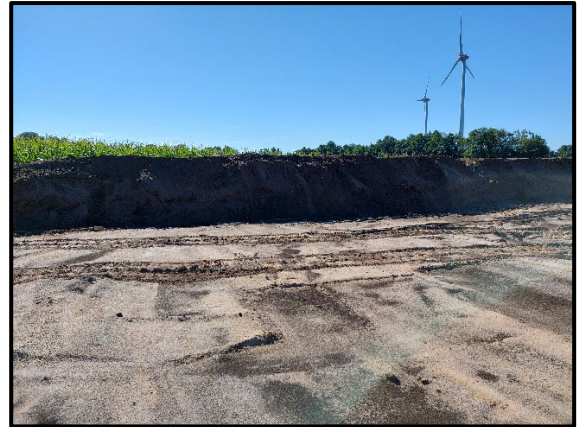
Foto 2: Erneuerung der Haufwerke und Reduzierung der Mächtigkeit auf 2 m.
