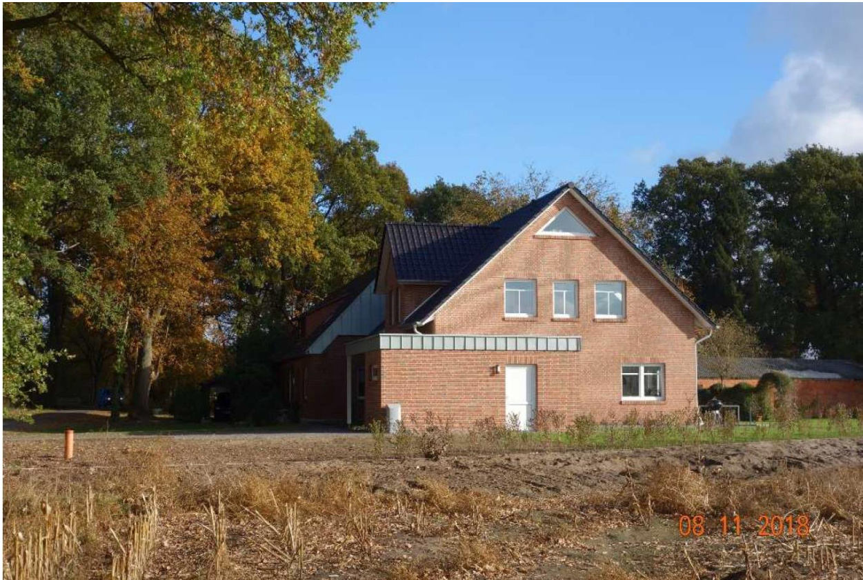
Abb. 13: Neu gebautes Wohnhaus Westmark 3a (entnommen aus dem Schattengutachten) im Hintergrund Westmark 3.
