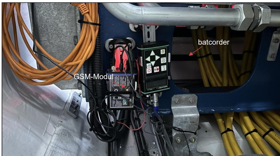
Abbildung 4: Beispiel eines verbauten batcorders und GSM-Moduls in einer Gondel.
