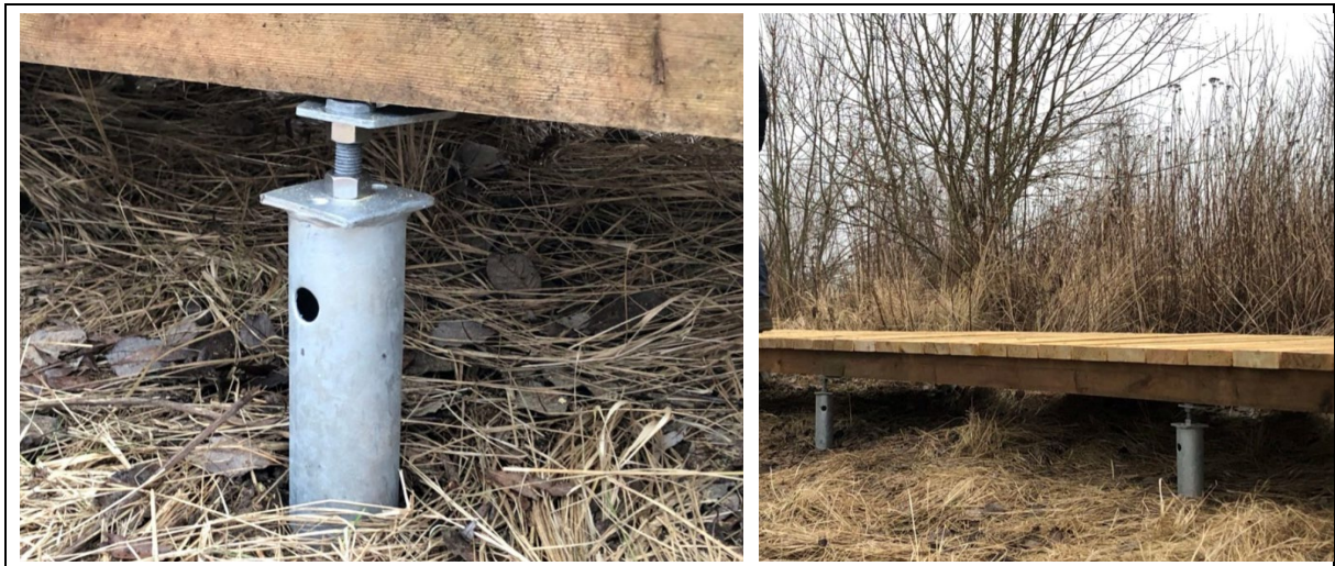
Abbildung 18: Beispiel eines Bohlenweges (Schraubfundamente, Robinienbohlen und Konstruktionsbalken)
