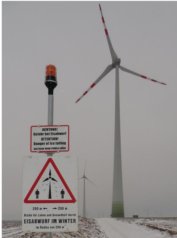
Abb. 1: Möglicher Aufbau einer Eiswarnleuchte mit zusätzlichen Warnschildern
