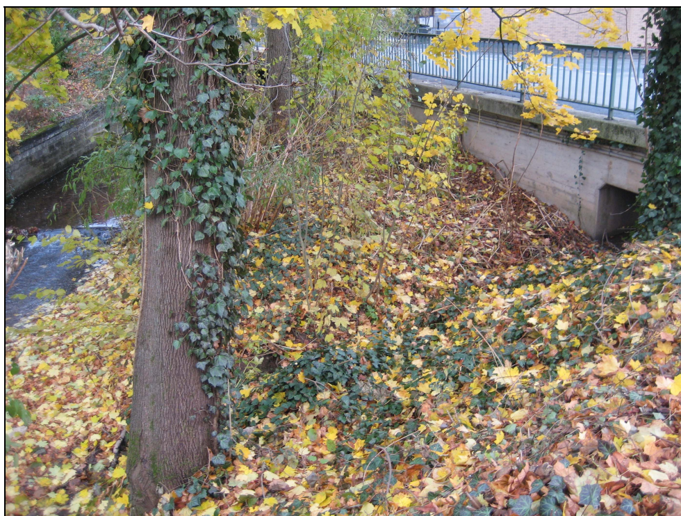
Abb. 8.16 Vorhandener Durchlass im Unterlauf des Mühlengrabens (Quelle [L+N])
