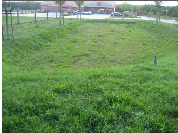
Abb. 8.23 Versickerungsbecken (Quelle [L+N])
