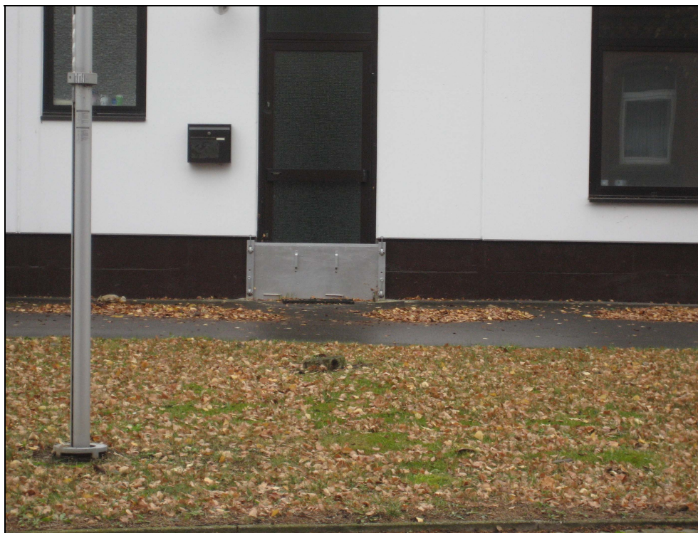
Abb. 1.7 Mobile Schutzvorrichtung (Quelle L+N)
