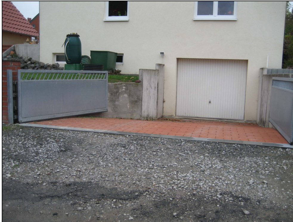
Abb. 1.9 Schutzvorrichtung verschließbares Tor (Quelle L+N)
