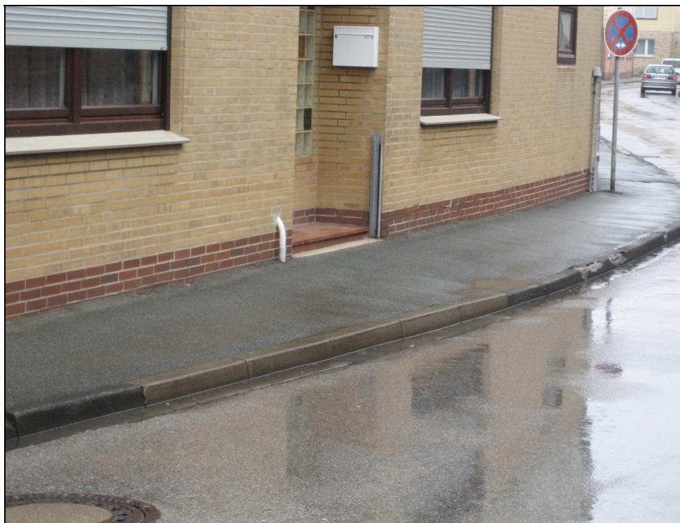
Abb. 1.5 Mobile Schutzvorrichtungen im Eingangsbereich (Quelle [55])
