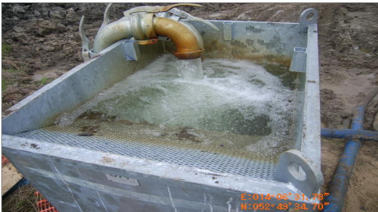
Abbildung 4: Beispiel eines vorgeschalteten Klär- und Absetzbeckens
