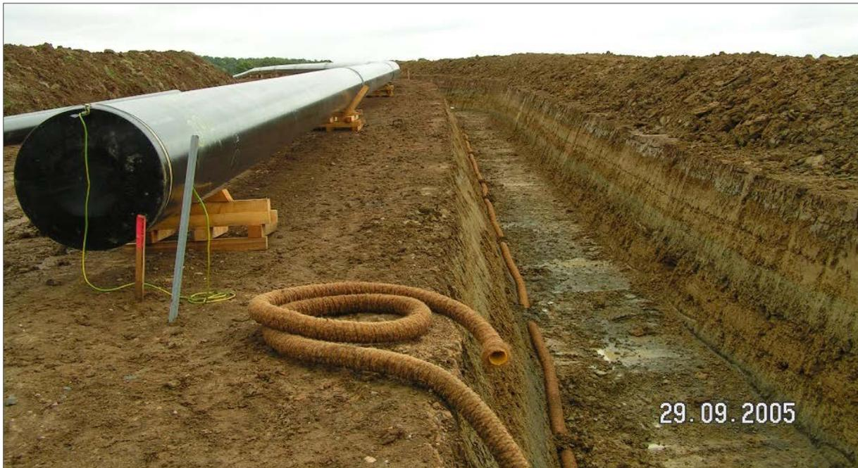
Abbildung 5: Beispiel offener Rohrgraben
