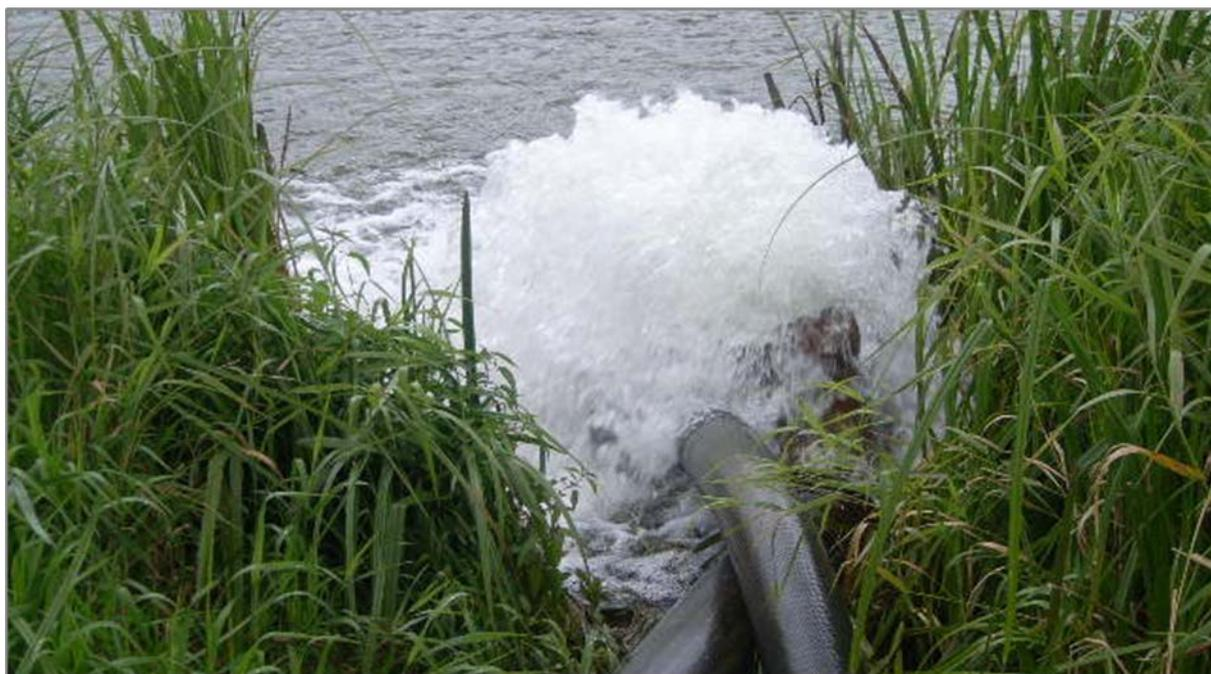
Abbildung 3: Beispiel einer Einleitung von Bauwasser
