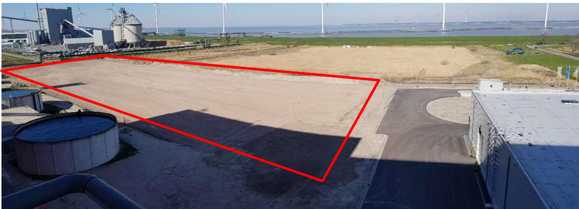
Figuur 1 De geplande locatie voor 4 de lijn van EEW aan de noordzijde van de huidige installatie. De foto is genomen vanaf het dak van het gebouw. (Bron: foto uit eigen bestand)
