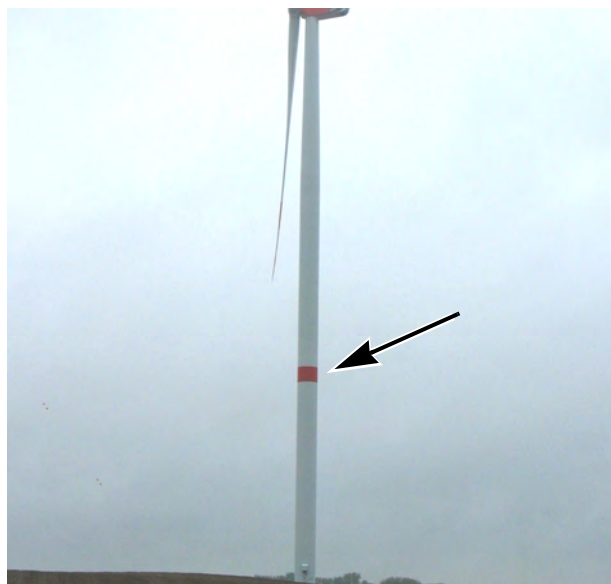
Abb. 4 Roter Farbring an Anlage mit Gesamthöhe >150 m
