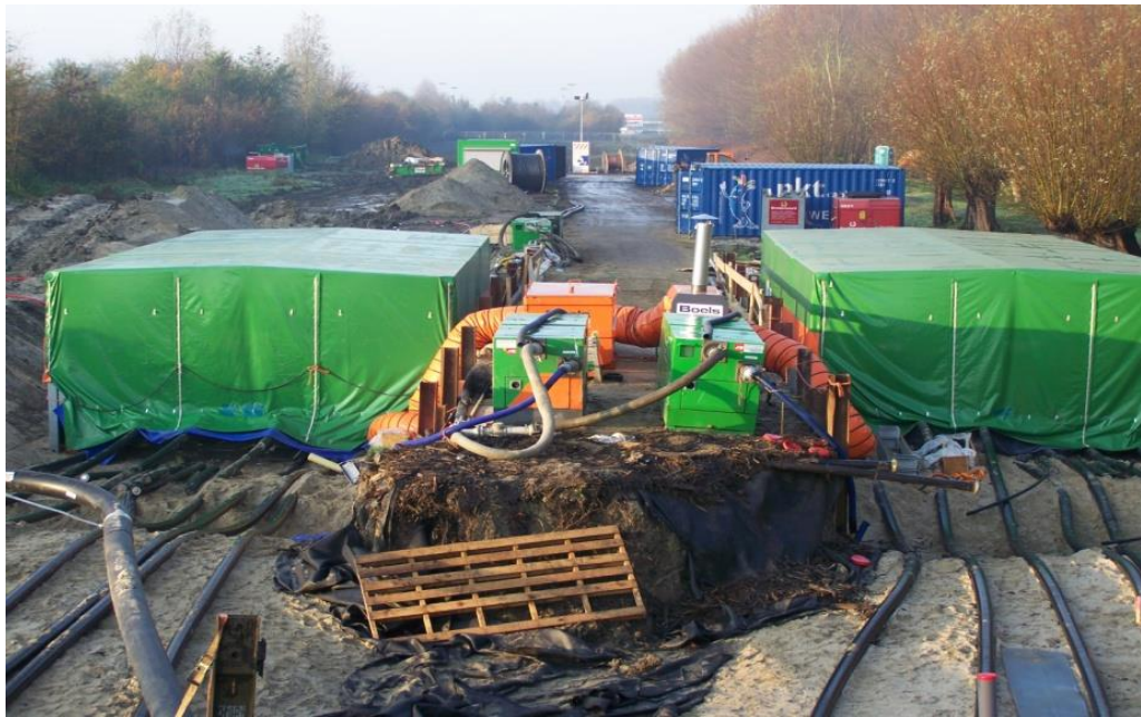
Abb. 3.4-4 Muffengrube mit Arbeitscontainer (Quelle: TenneT)
