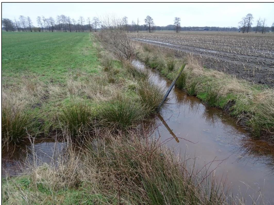
Abbildung 3: Graben bei Maßnahme S-2. Der zu verrohrende Graben ist deutlich über 1 m breit.
