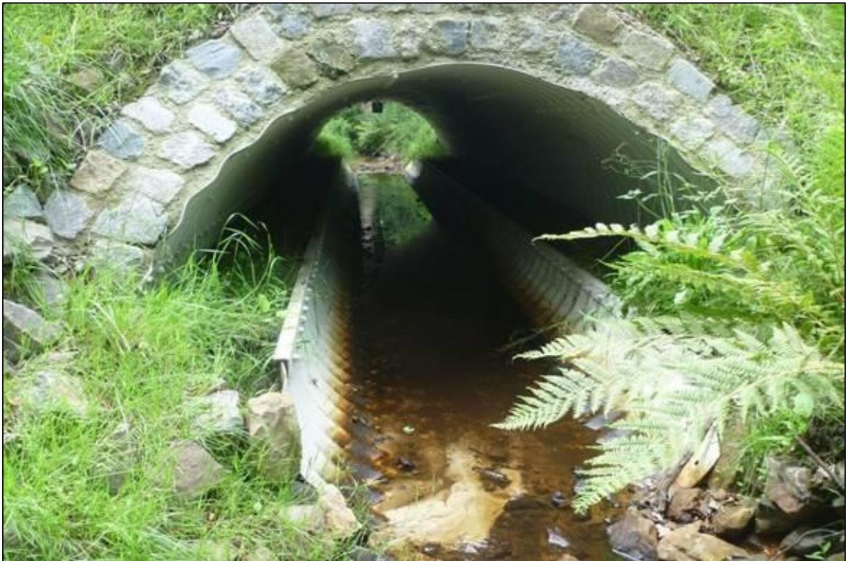
Abbildung 8: Bogenförmige Steinbrücke mit Wellenprofil (Quelle: <https://www.hamco-gmbh.de>).
