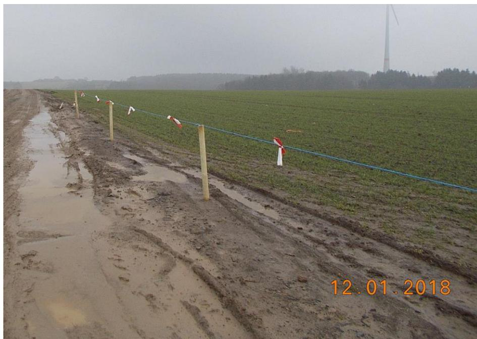
**Abb. 18:** Beispiel einer Baufeldbegrenzung mittels Pfosten, Spanschnur und *Flutterband*
