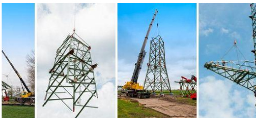
Abbildung 19: Stocken eines Freileitungsmastes (Quelle: TenneT TSO GmbH)
