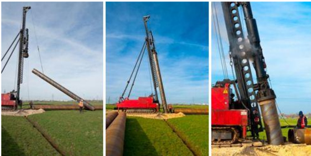
Abbildung 18: Pfahlgründung (Quelle: TenneT TSO GmbH)
