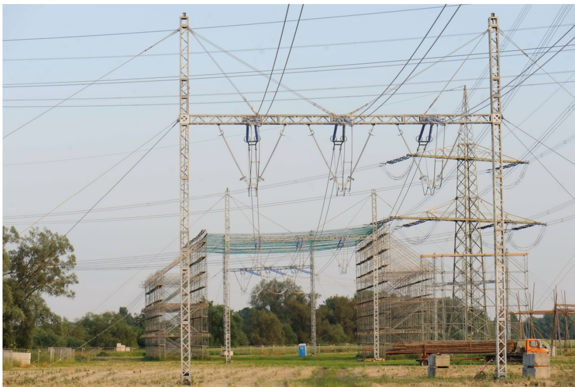
Abbildung 31: 380-kV-Freileitungsprovisorium für ein System, mit errichtetem Schutzgerüst
