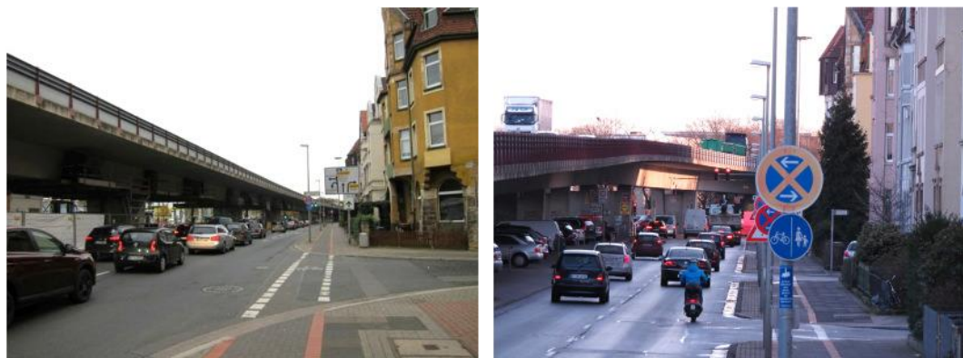
Abbildung 26: Bestandssituation südliche Willmerstraße, Blick in Richtung Osten, © R+T & topp.plan (2017)
