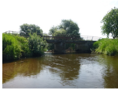
Abb.: 6.7: Übersichtsfoto der Probestelle 2; flussaufwärts
