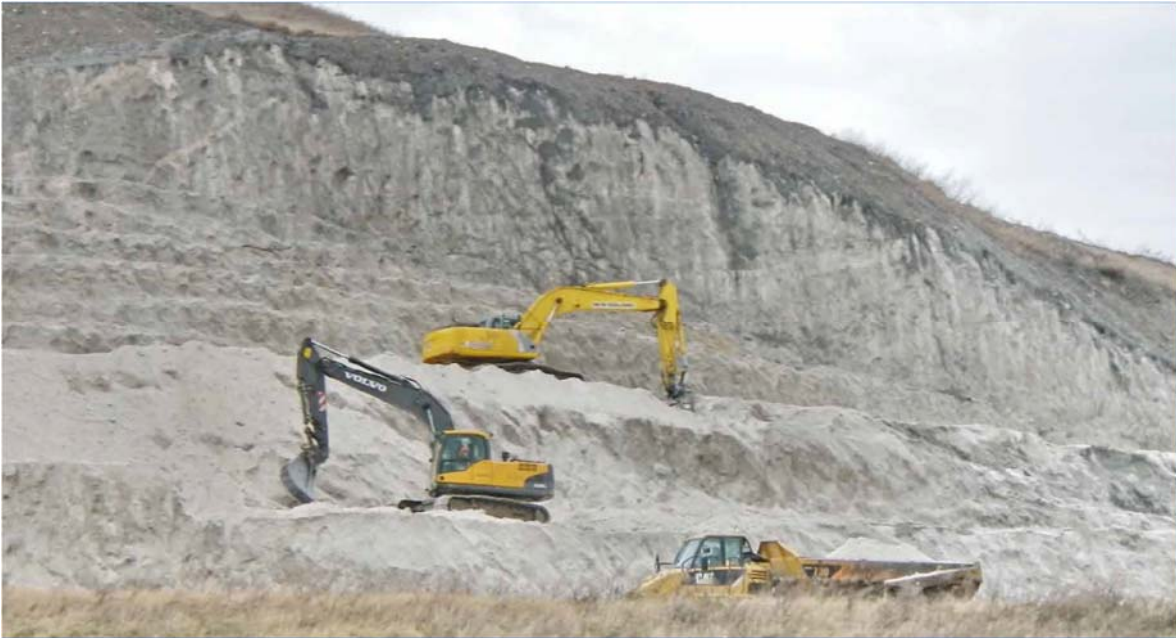
Abbildung 1: Profilierung durch Abfräsen Salzhalde Friedrichshall [5]
