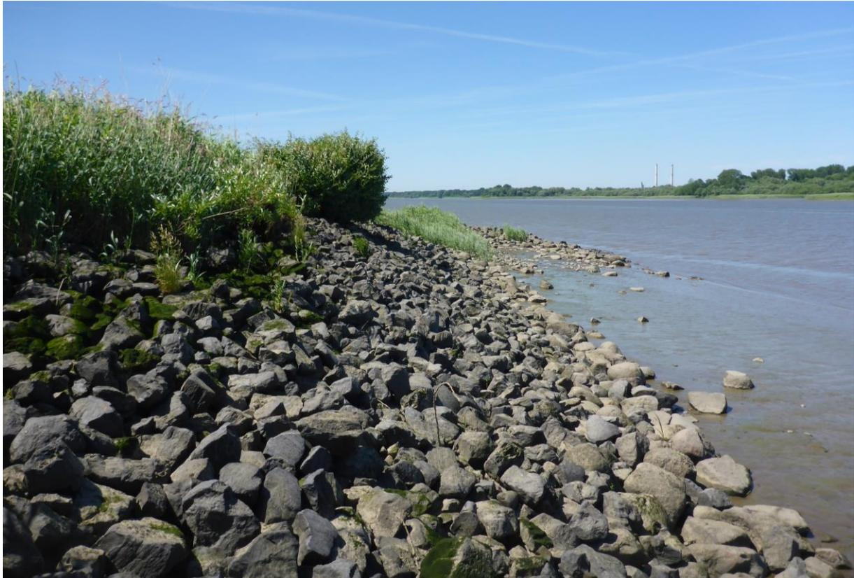
**Abb. 9:** Ufersicherung (Stat. 0+520), Blickrichtung West
