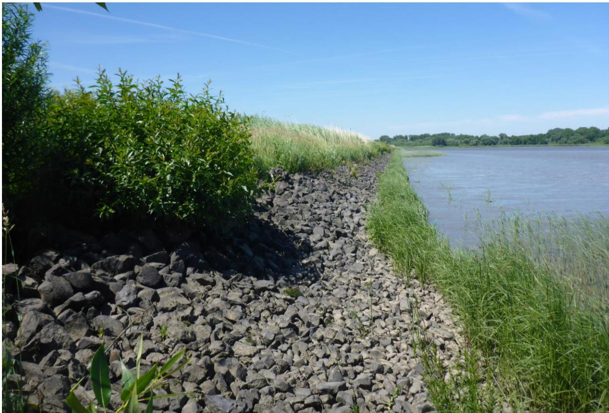
**Abb. 4:** Ufersicherung (Stat. 0+100), Blickrichtung Nord-West
