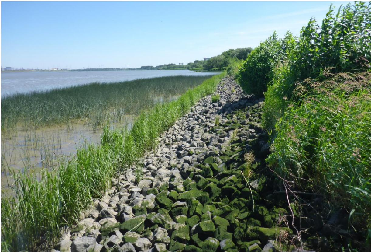
**Abb. 6:** Ufersicherung (Stat. 0+350), Blickrichtung Süd-Ost
