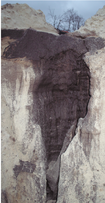
Abb.11: Rinnen Auskleidung durch Huminsäuren unbeschädigt
