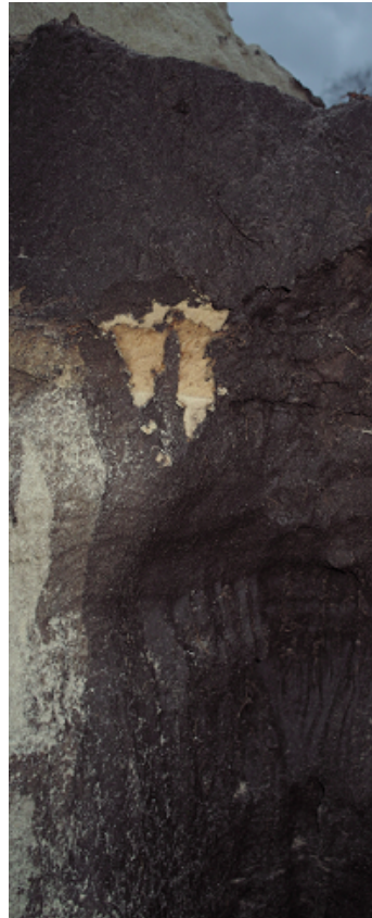
Abb.12: Rinnen Auskleidung durch Huminsäuren angekratzt
