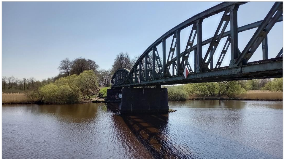
Abb. 18: Blick auf das Brückenbauwerk vom westlichen Widerlager (April 2021)
