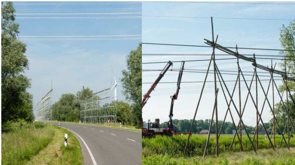
Abbildung 31: Beispiele für Schutzgerüste aus Stahl bzw. Holz
