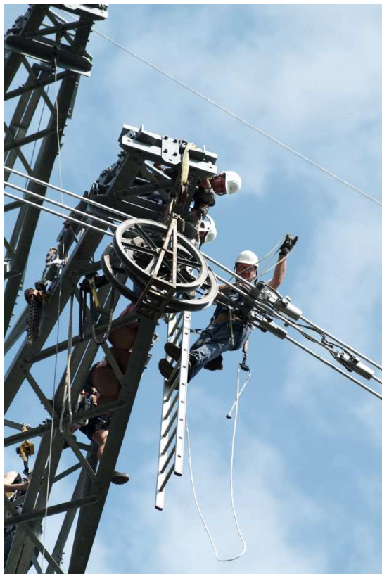
Abbildung 18: Seilzug (Quelle: TenneT TSO GmbH)
