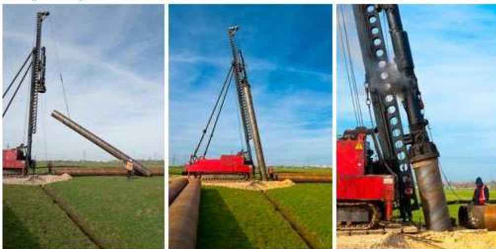
Abbildung 16: Pfahlgründung (Quelle: TenneT TSO GmbH)
