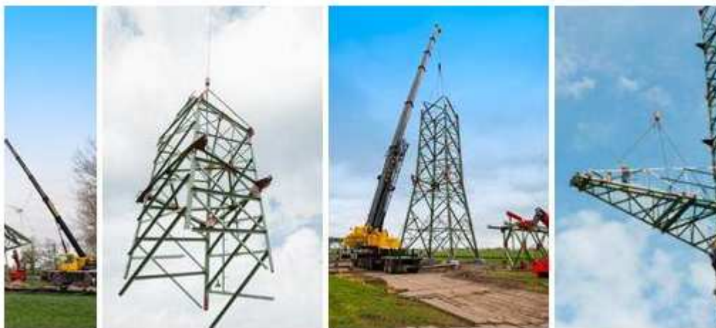
Abbildung 17: Stocken eines Freileitungsmastes (Quelle: TenneT TSO GmbH)
