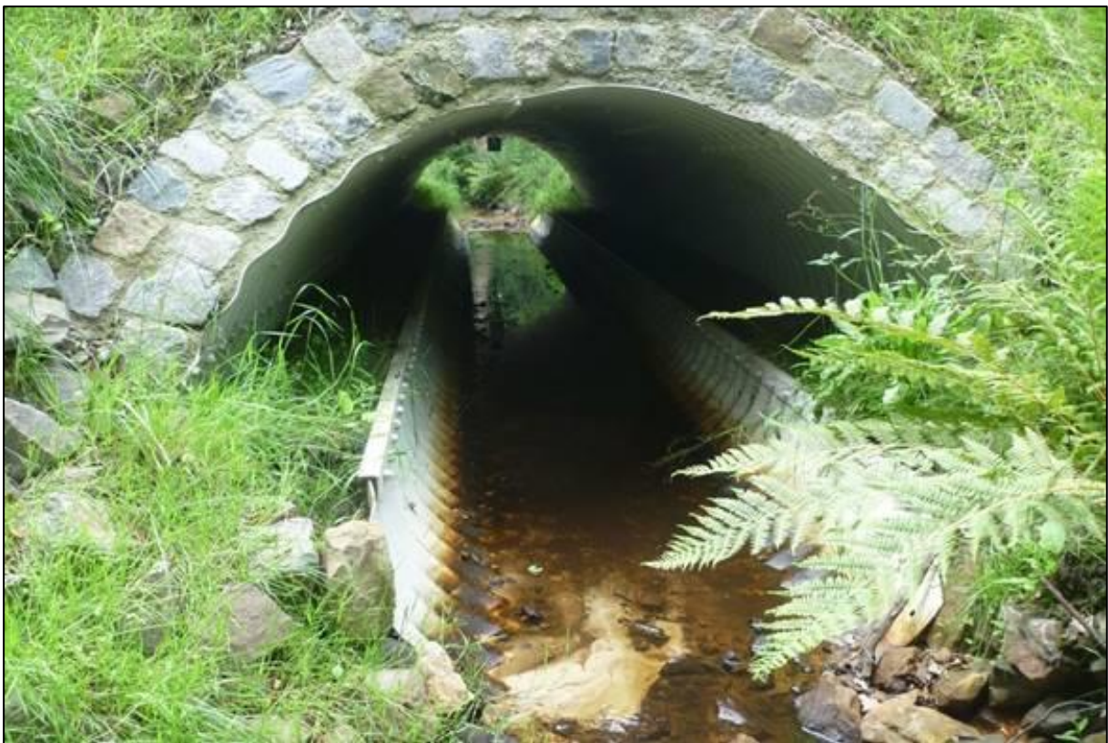
Abbildung 8: Bogenförmige Steinbrücke mit Wellenprofil (Quelle: https://www.hamco-gmbh.de ).
