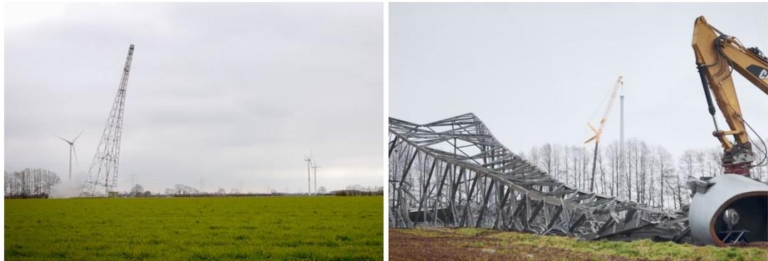
**Abbildung 8** Bilder der Sprengung (links) und Demontage eines Gittermastturmes einer Vestas V47 in Bremen © Deutsche Windtechnik
