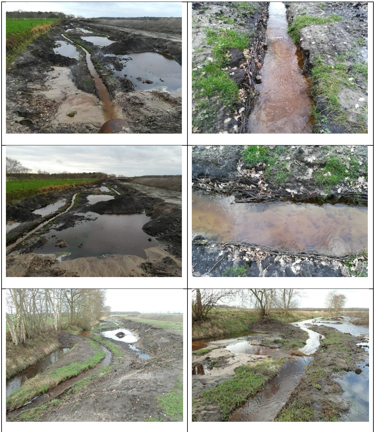
Abb. 6: Eindrücke der Renaturierungsmaßnahme an der Bekhauser Bäke im Bereich der Abschnitte 3000/3100 (Bilder links und rechts unten), sowie in den noch nicht angeschlossenen Bereichen (Bilder mitte und oben), Februar 2020.
